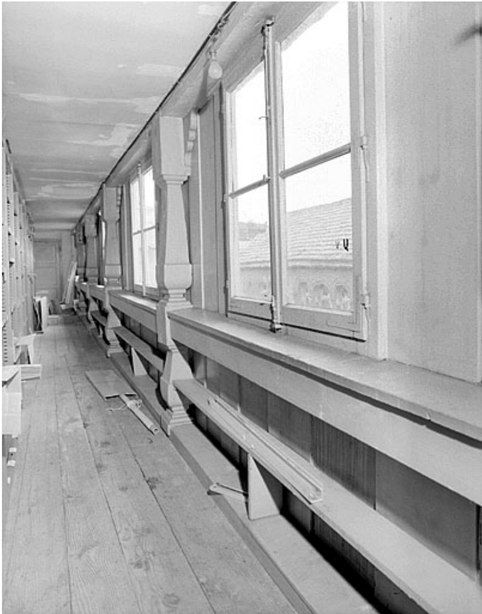
Galerie de distribution [au niveau du premier étage, partie occidentale).
