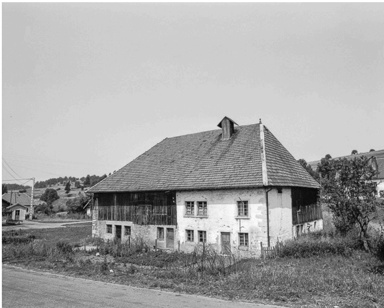
Ferme située au lieu-dit Colombière, cadastrée AB 73 : façades antérieure et latérale droite.
