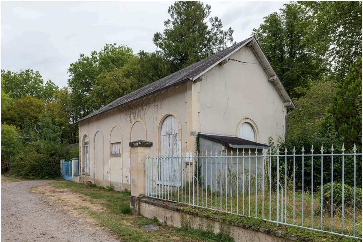
Vue depuis le sud.
