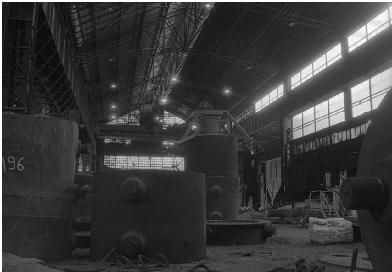
Extrémité nord de la halle des fours.
