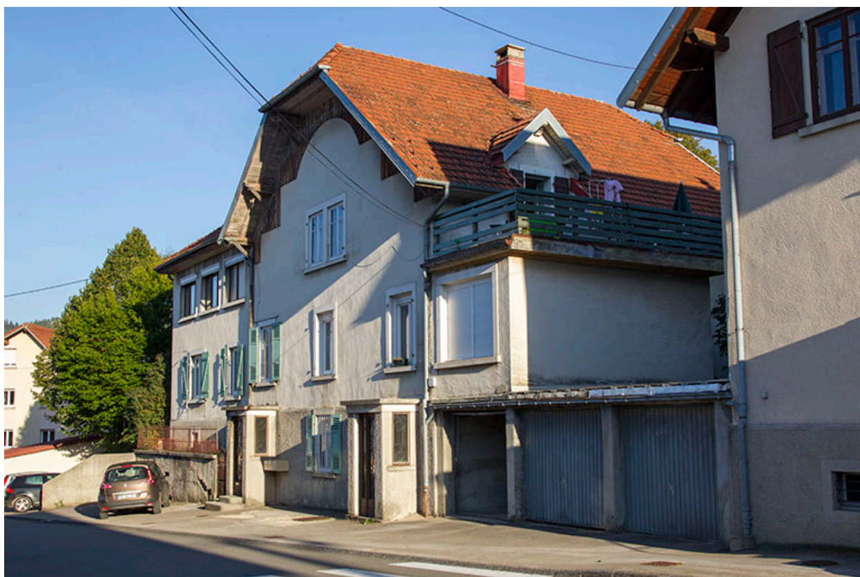
Maison : façade antérieure, vue en enfilade.
