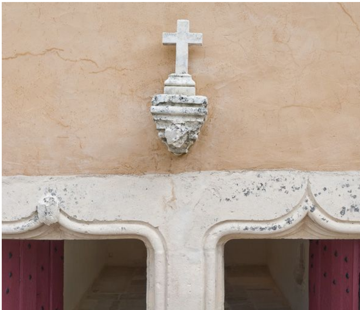
Détail des portes d'entrée en accolade.
