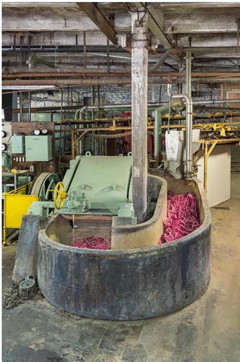
Usine à papier et cartonnerie dite manufacture de carton-cuir Hétier, Mesnay : pile raffineuse.
