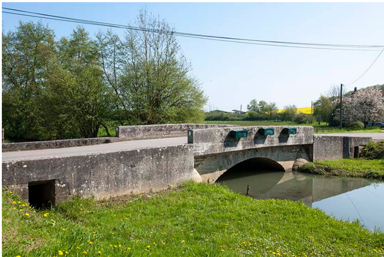
Le pont permettant de franchir le ruisseau.
