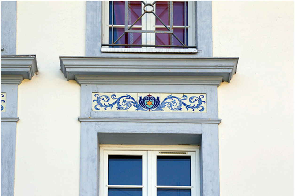
Premier atelier de fabrication, façade latérale gauche : décor entre deux fenêtres.
