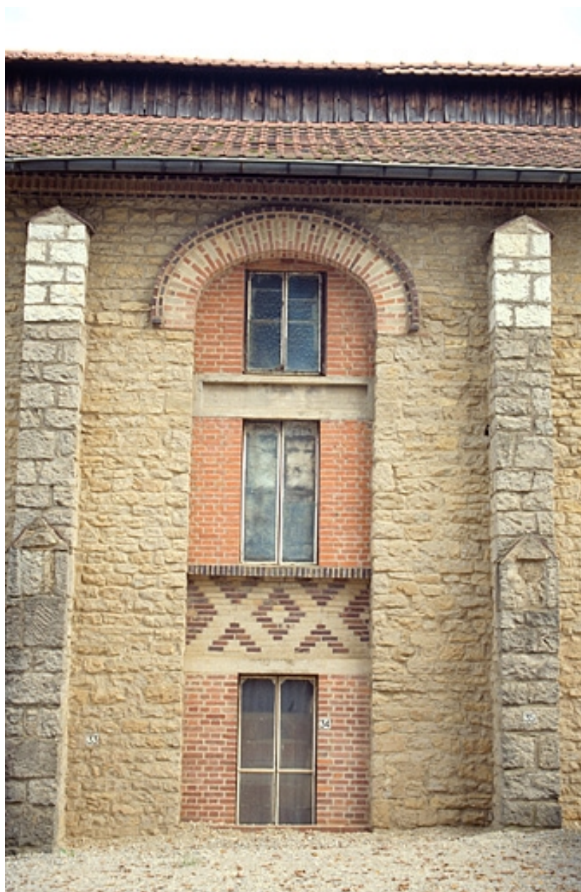
Atelier (A) : détail d'une travée étroite.
