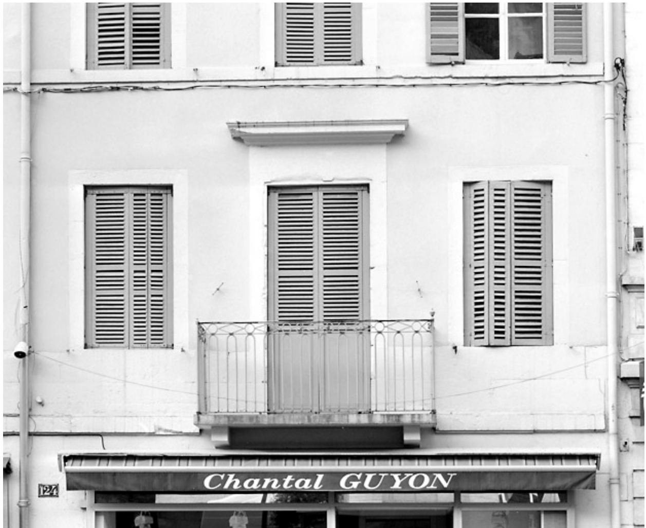
Premier étage du n° 124.
