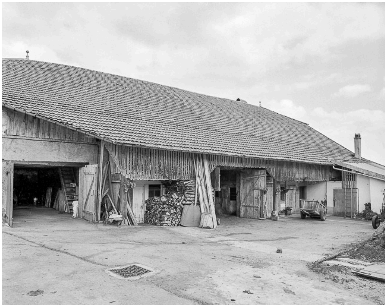
Mur goutterot d'une ferme.
