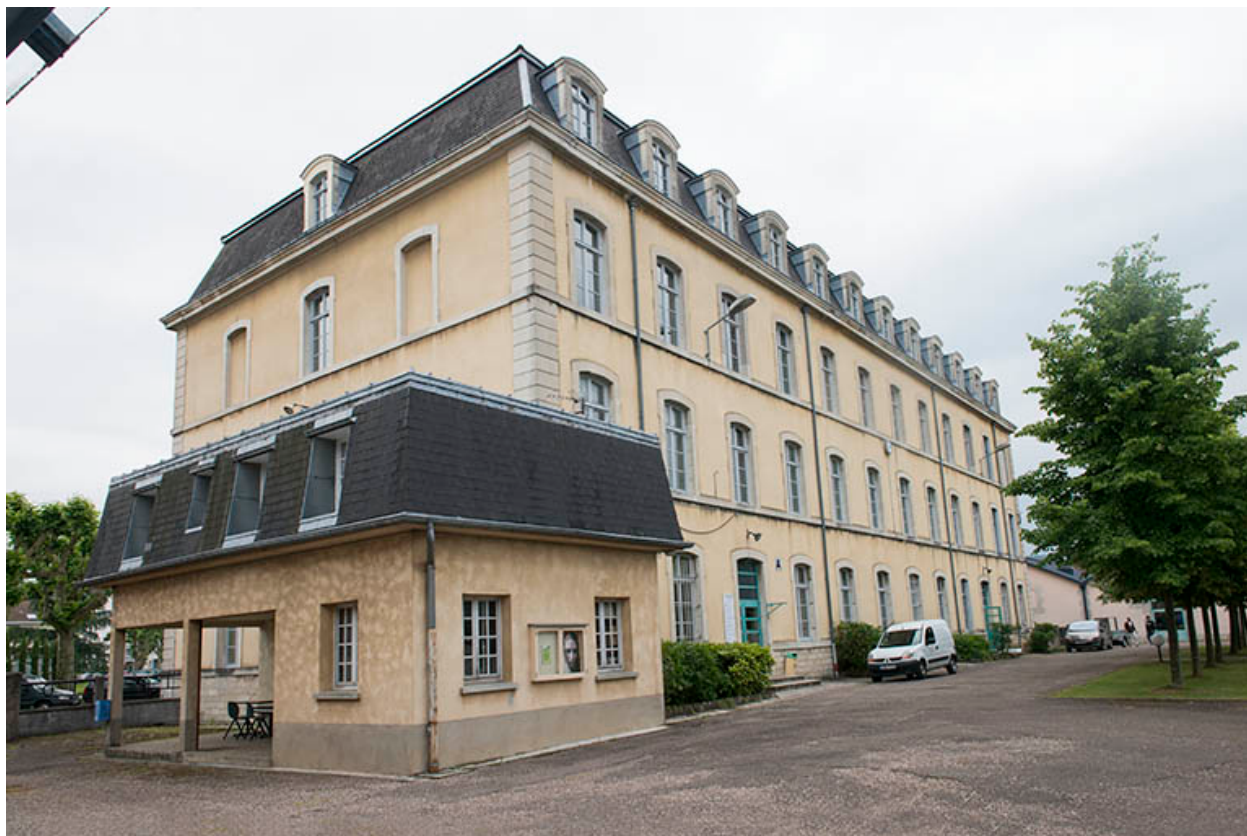
Pignon nord-ouest de l'administration-internat.
