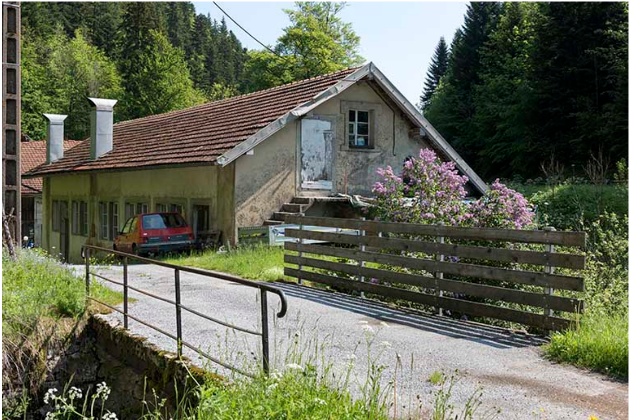
Usine : façades antérieure et latérale droite.
