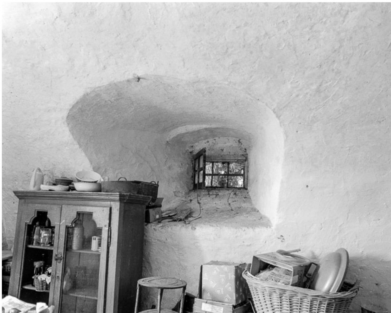
Ferme n° 16 : fenêtre de la cave.
