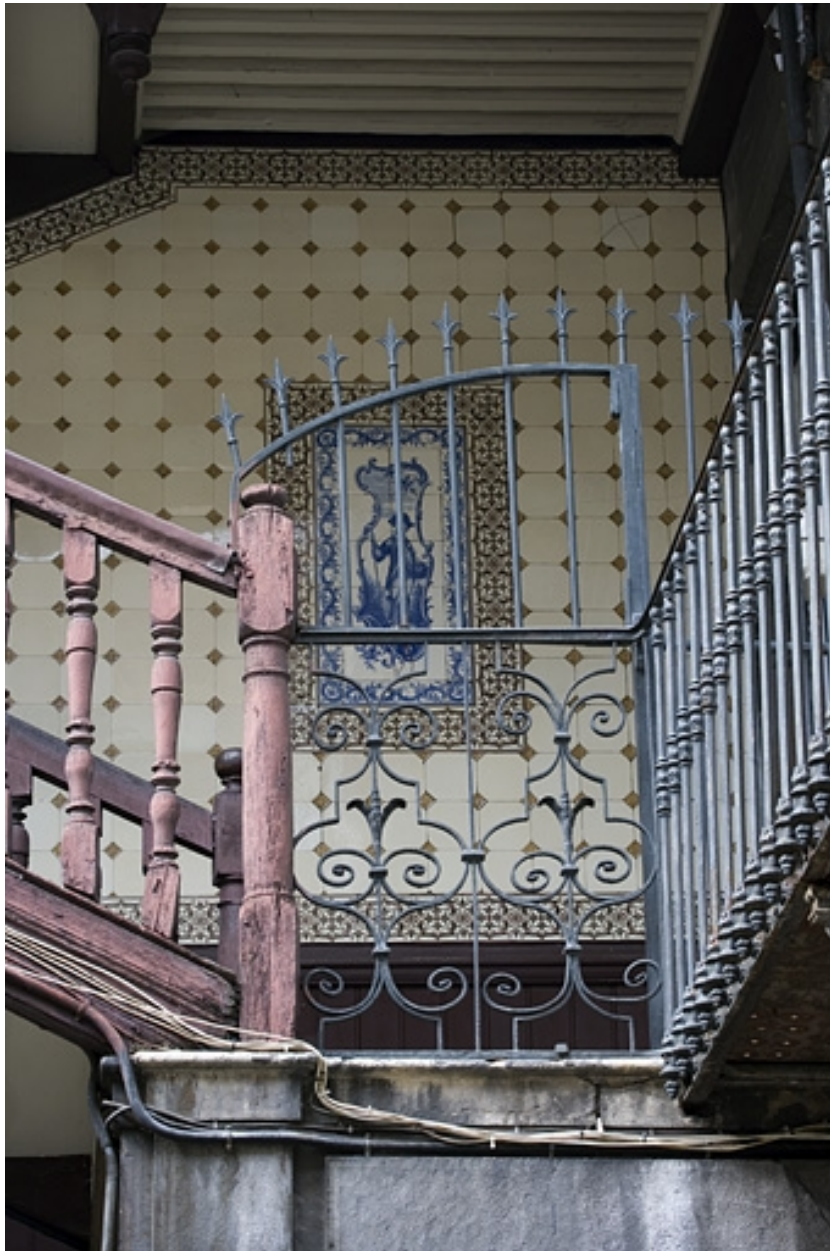
Escalier à cage ouverte : détail d'une partie en ferronnerie.
