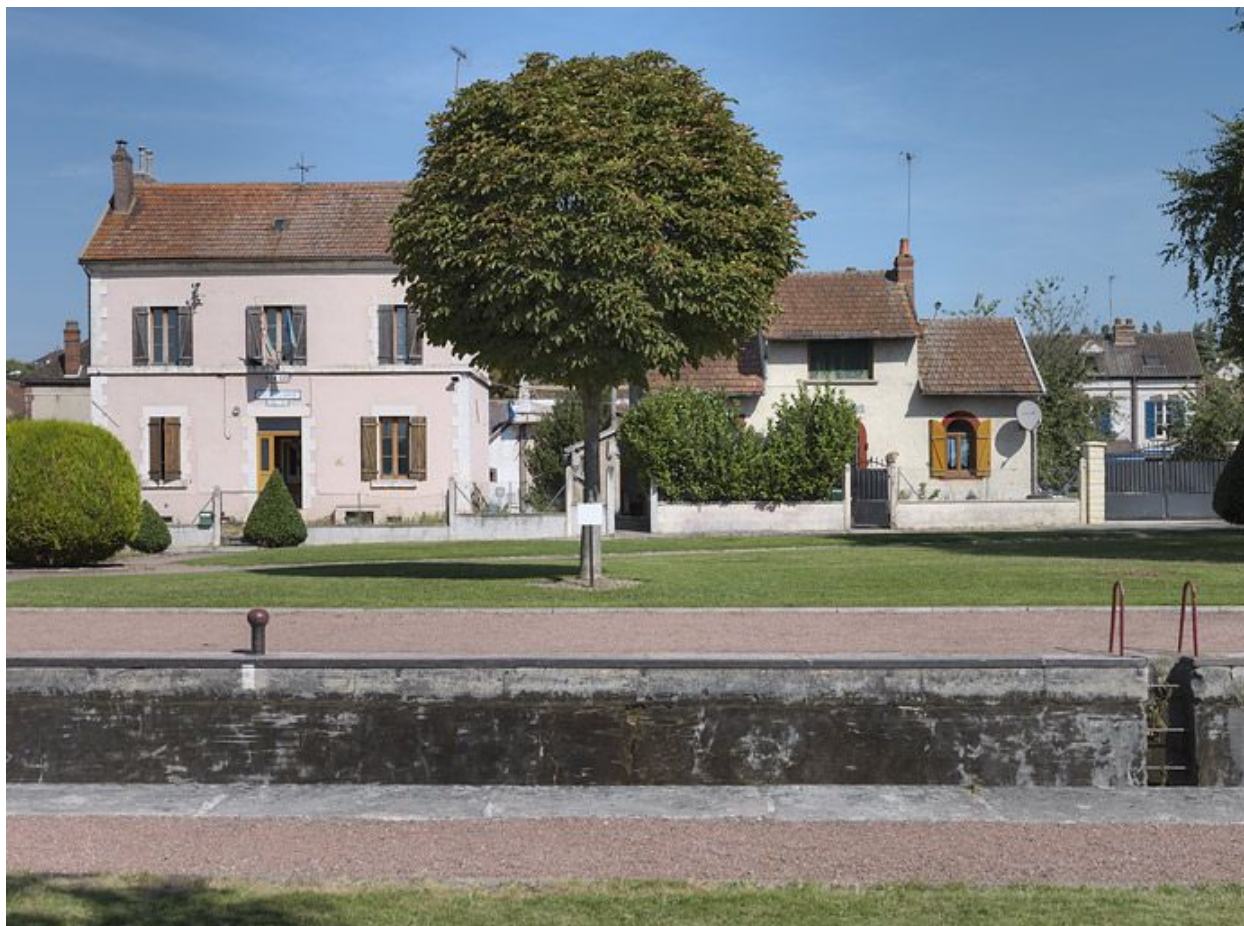
Les deux maisons de face.
