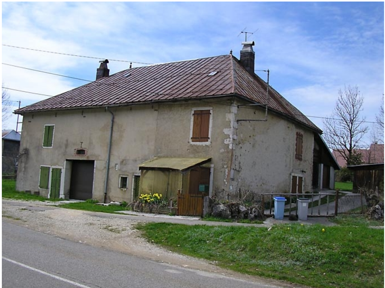
Ferme située au lieu-dit Le Maréchet.
