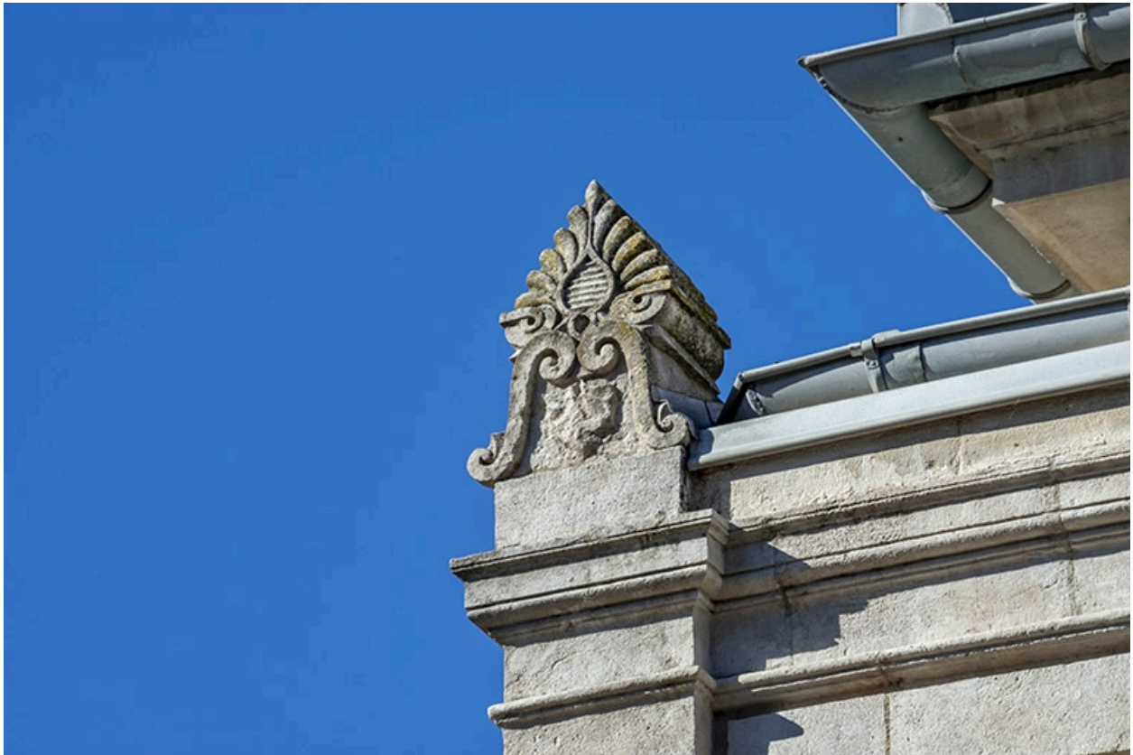
Façade antérieure : motif d'amortissement.
