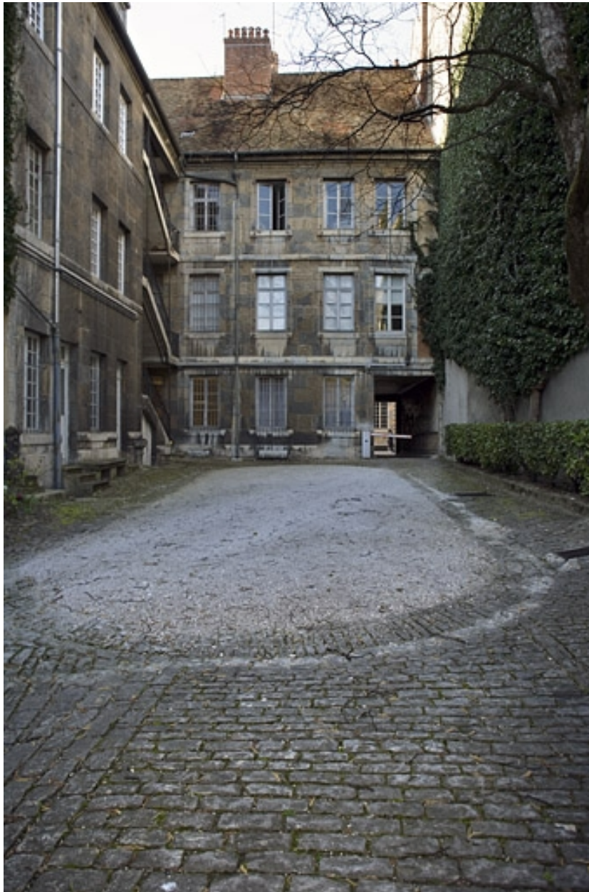
Vue d'ensemble de l'immeuble depuis le fond de la cour.
