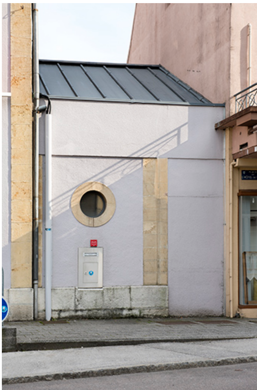
Façade antérieure : vestige de l'atelier de fabrication.
