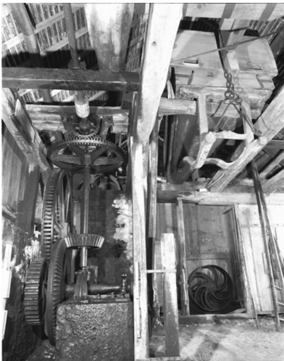
Vue d'un soufflet et du mécanisme.
