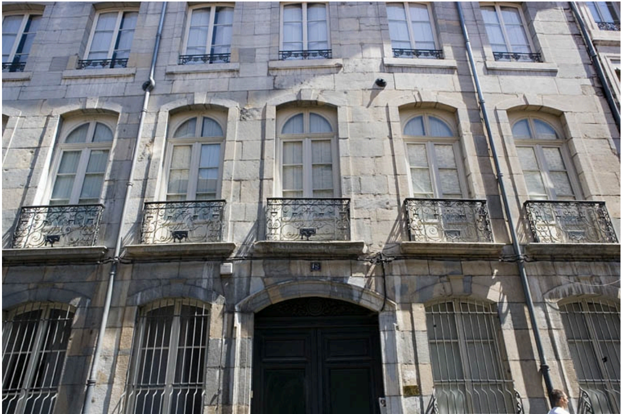
Logis principal : détail du premier étage sur rue.
