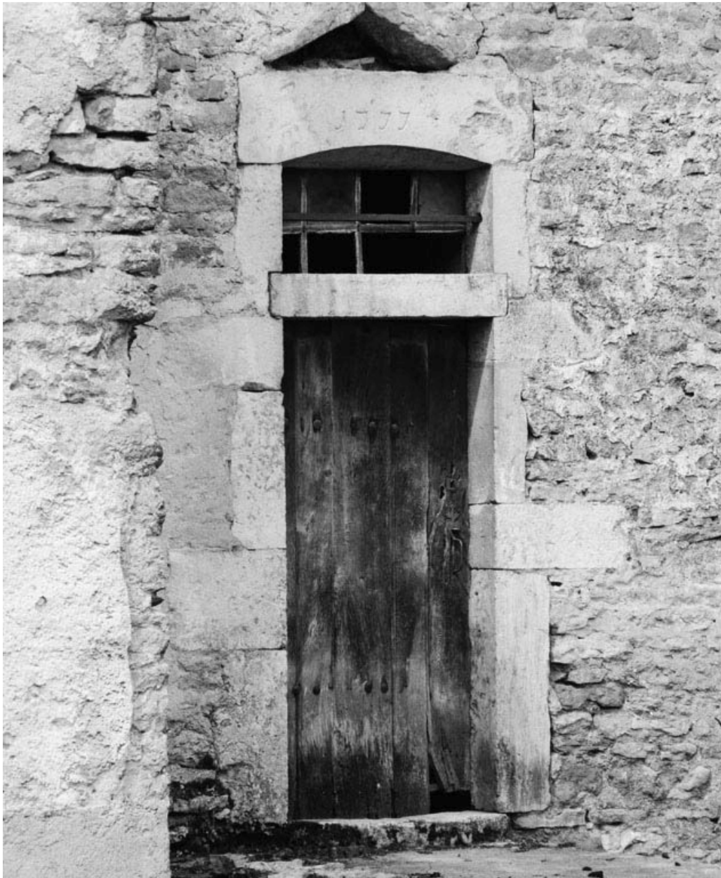
Détail de la porte.
