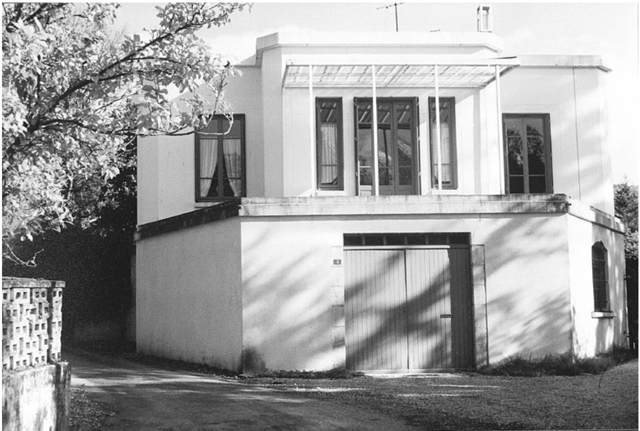
Façade antérieure avant restauration, novembre 1990.
