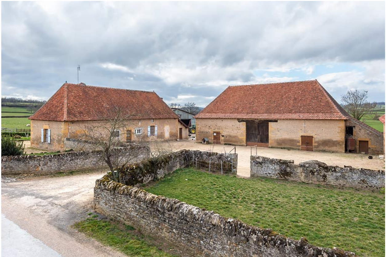
Vue de la maison, au sud, et de la grange, au fond de la cour, à l'ouest.
