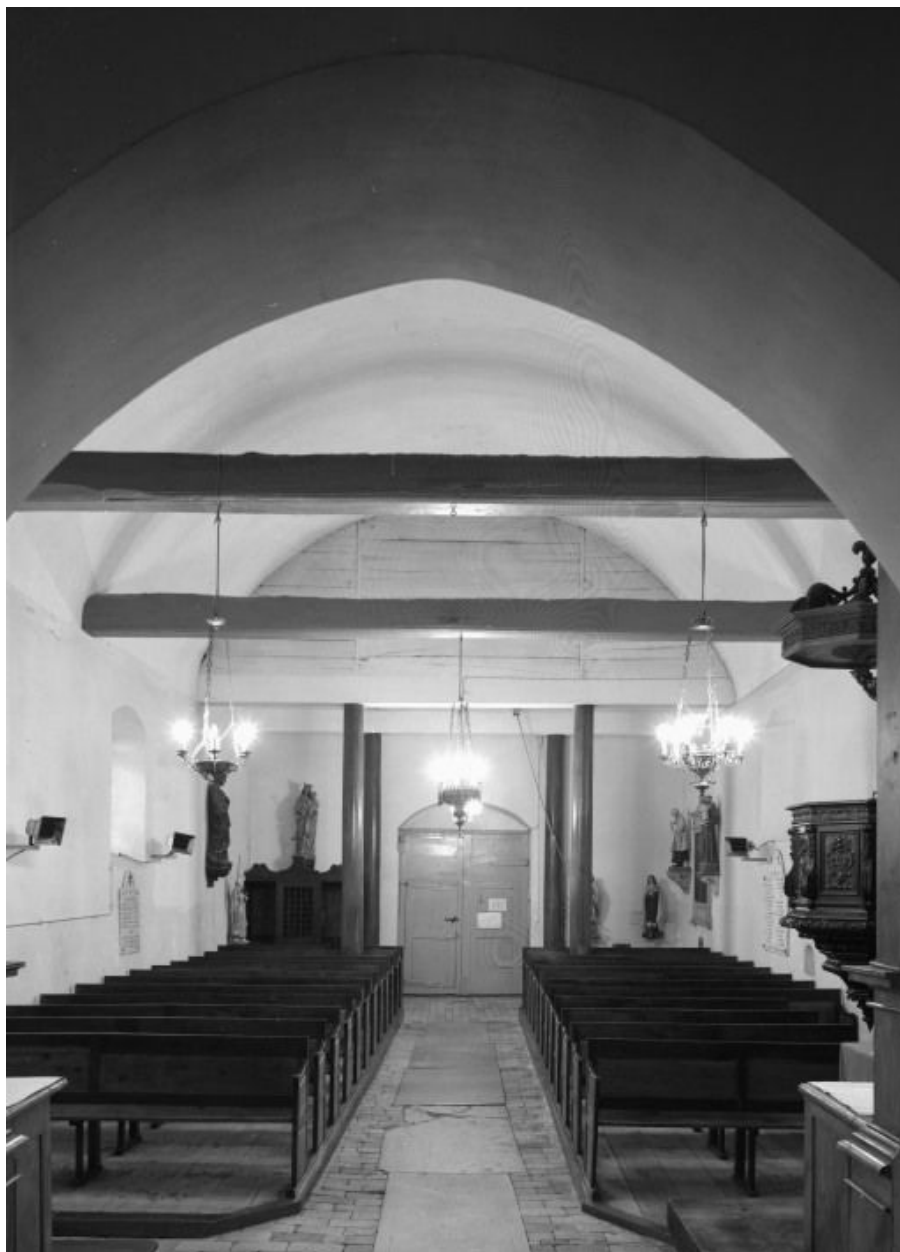
Vue d'ensemble depuis le chœur.
