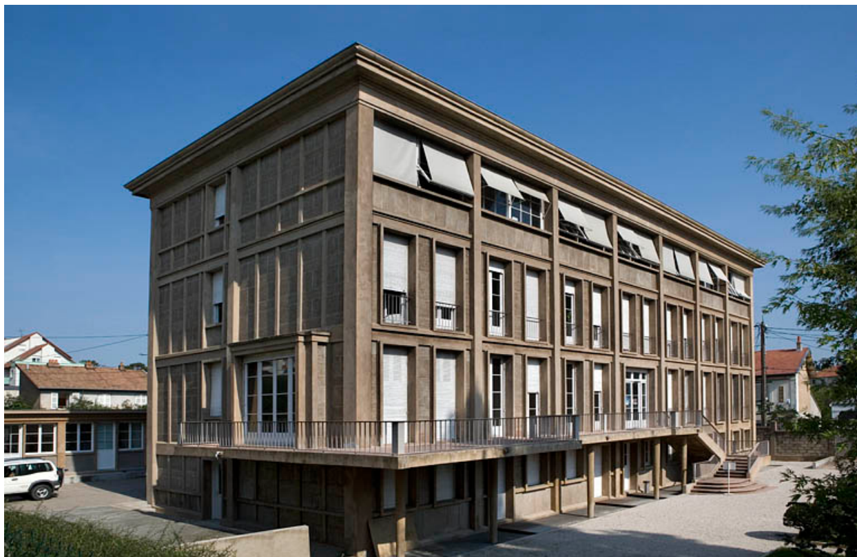
Façades postérieure et latérale gauche.
