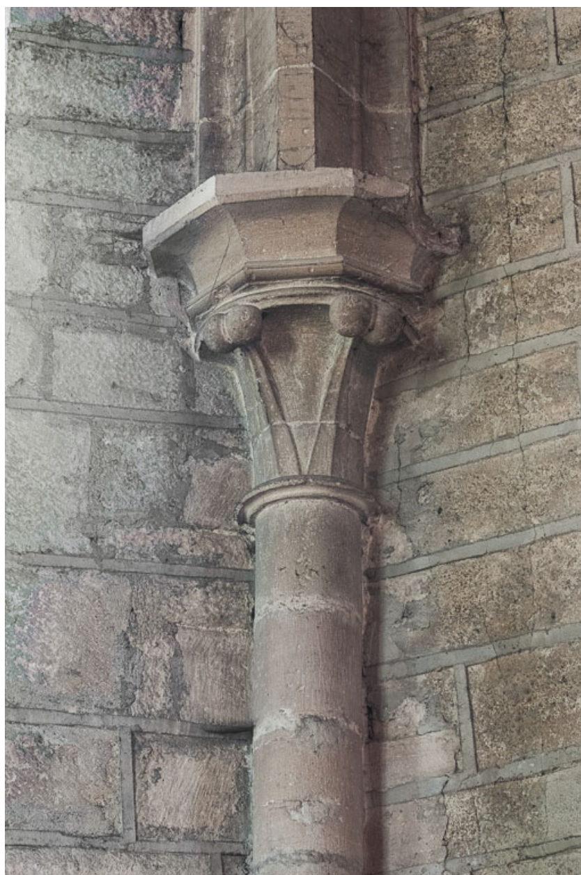
Vue d'un chapiteau du choeur.
