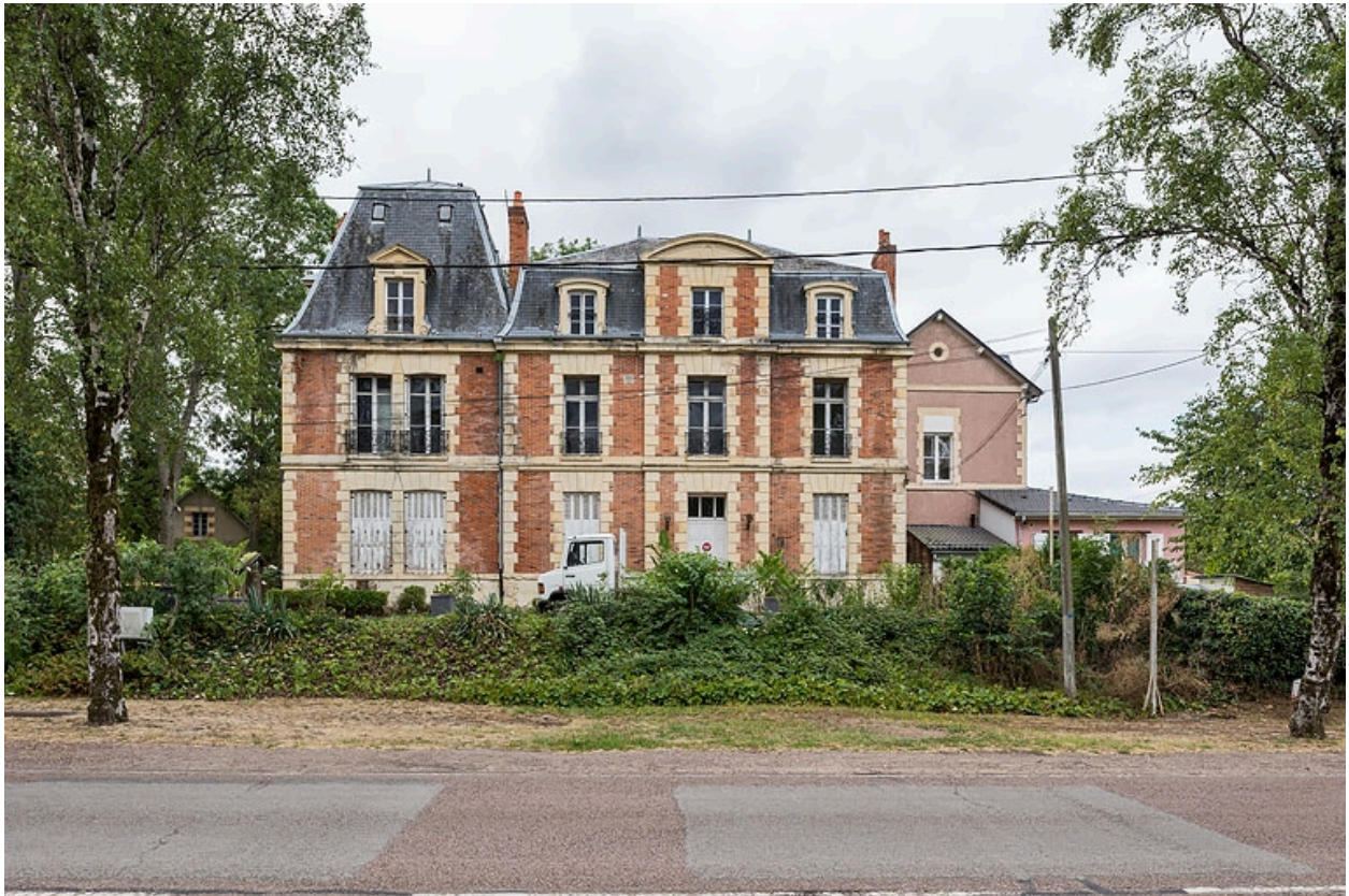
Façade sur l'avenue de Paris, vue de face.
