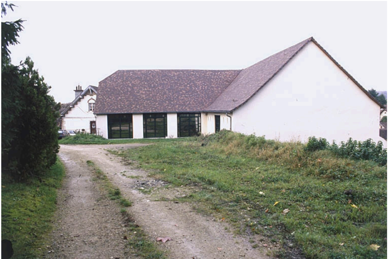
Ancienne halle à charbon depuis l'est.
