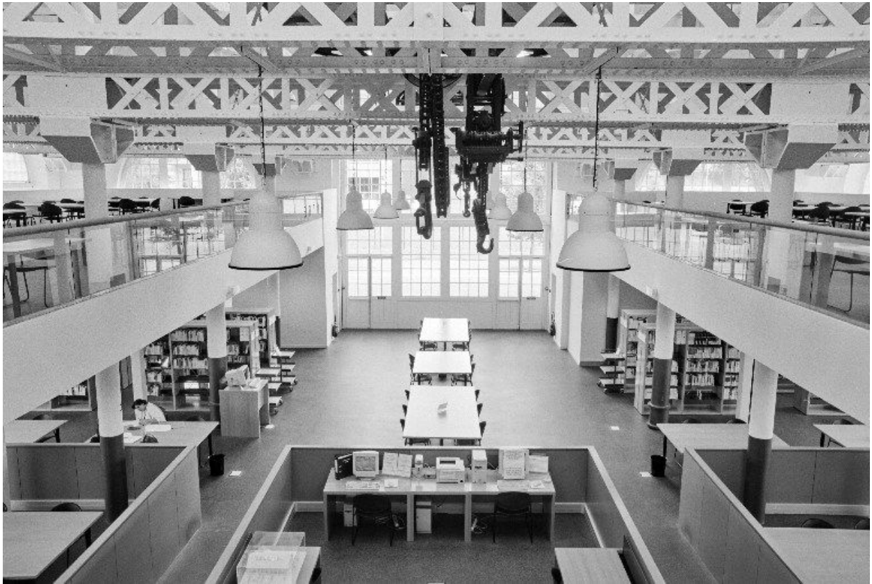
Vue intérieure de la halle des grues et des locos. Travée centrale.
