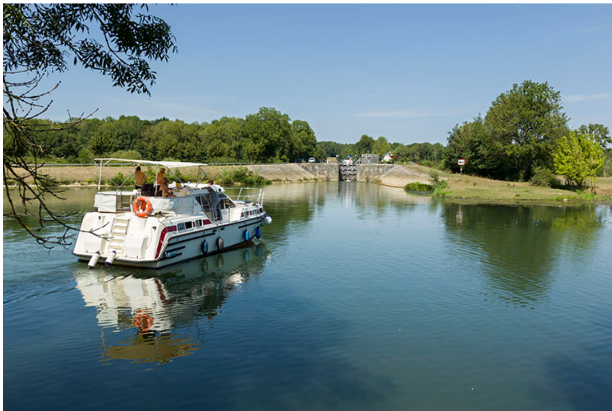
Entrée aval du bief de Savoyeux.
