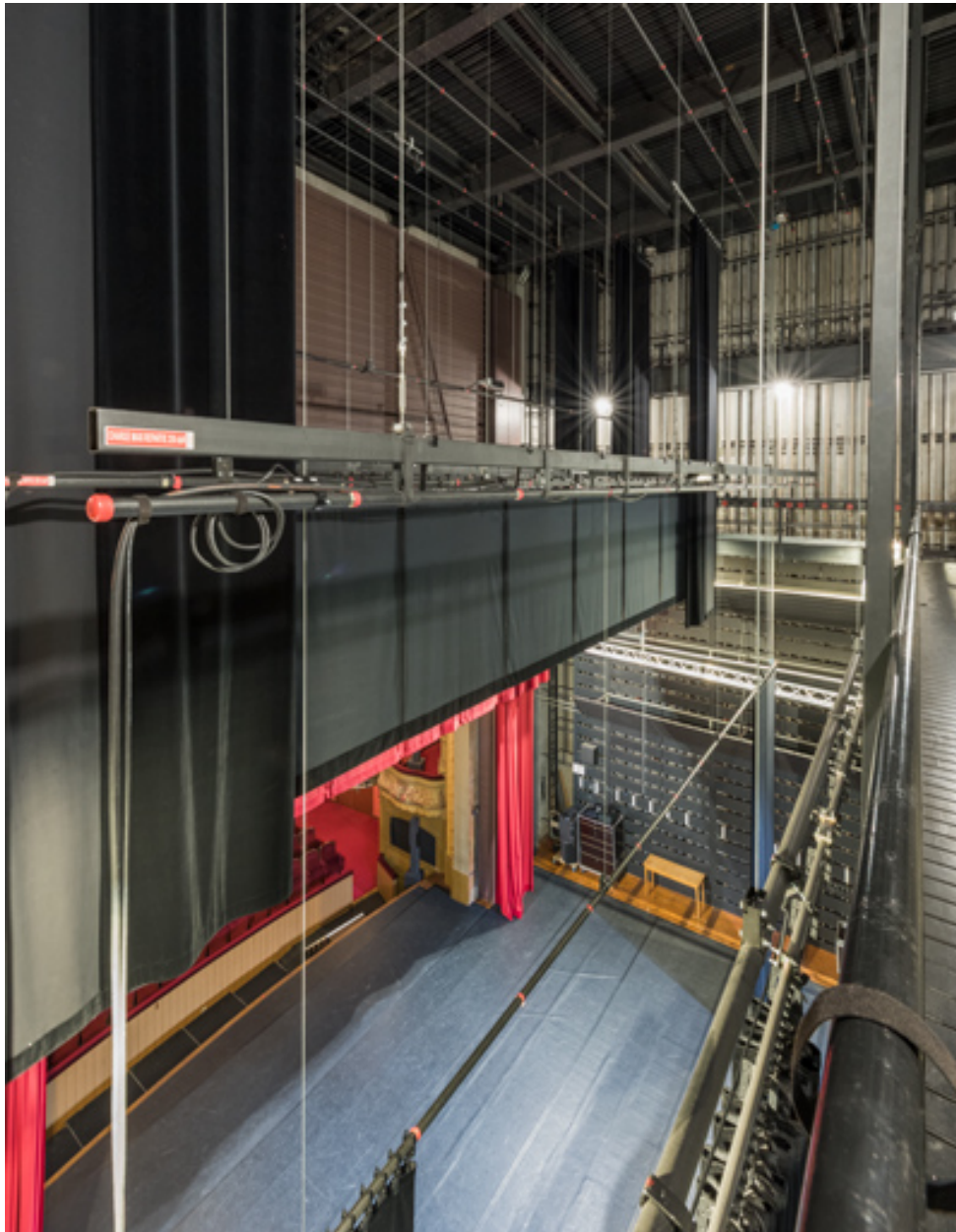
Cage de scène : vue plongeante sur le plateau depuis une passerelle.
