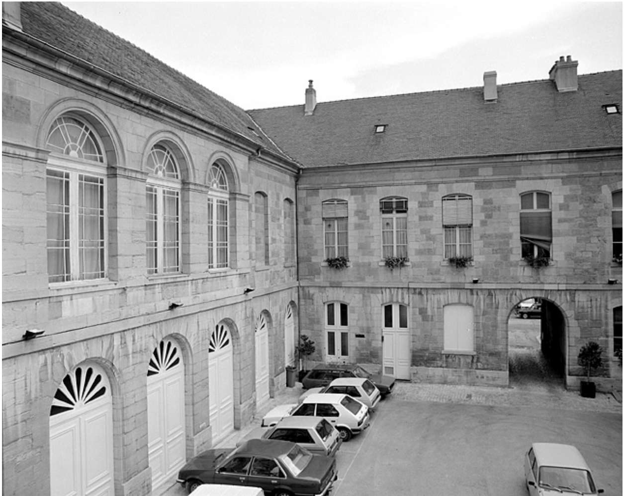
Cour intérieure : côtés nord et est.
