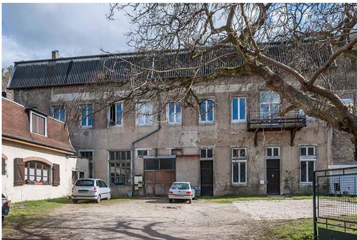
Façade antérieure de l'atelier de fabrication.
