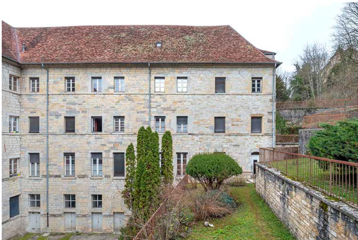
Façade sud de l'aile nord.
