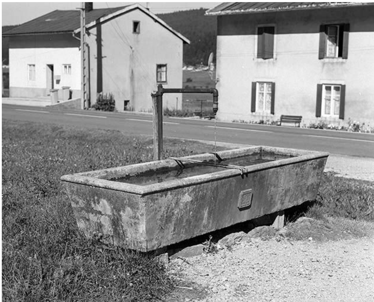
Bassin à proximité de la ferme.
