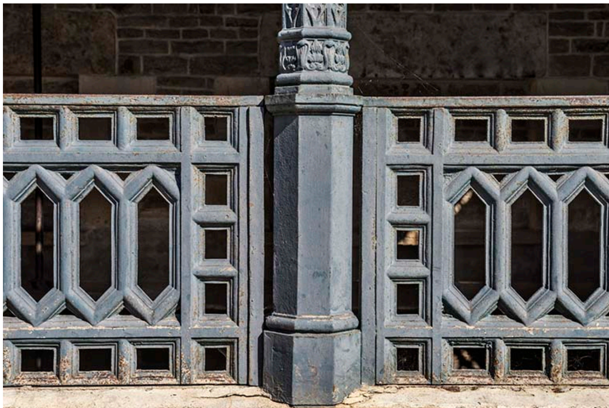
Détail du garde-corps et d'une colonne.
