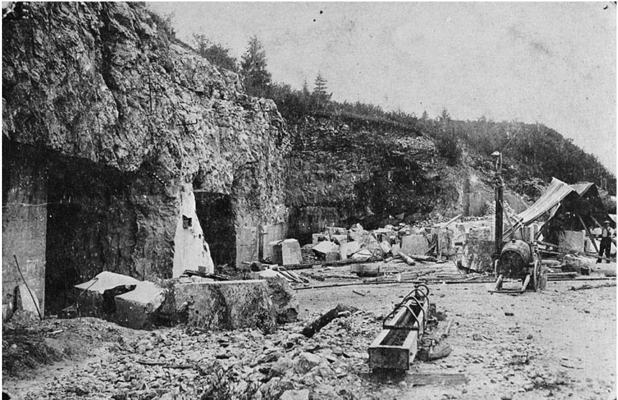
Chantier et entrées de la carrière souterraine.
