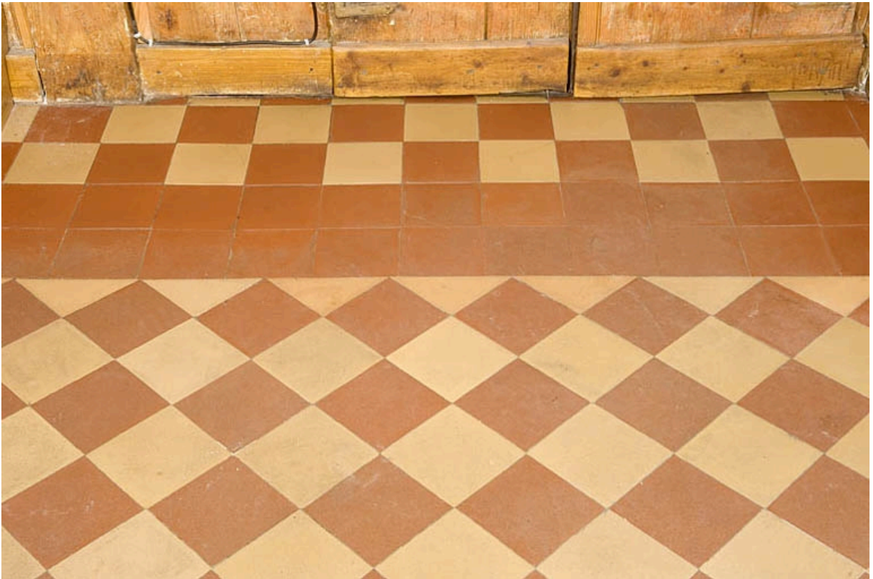
Cuisine du rez-de-chaussée : carreaux au sol.
