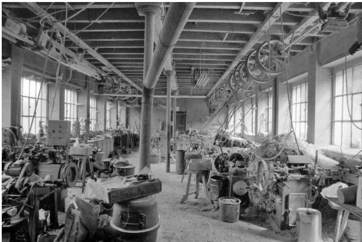
Intérieur de l'atelier de fabrication.
