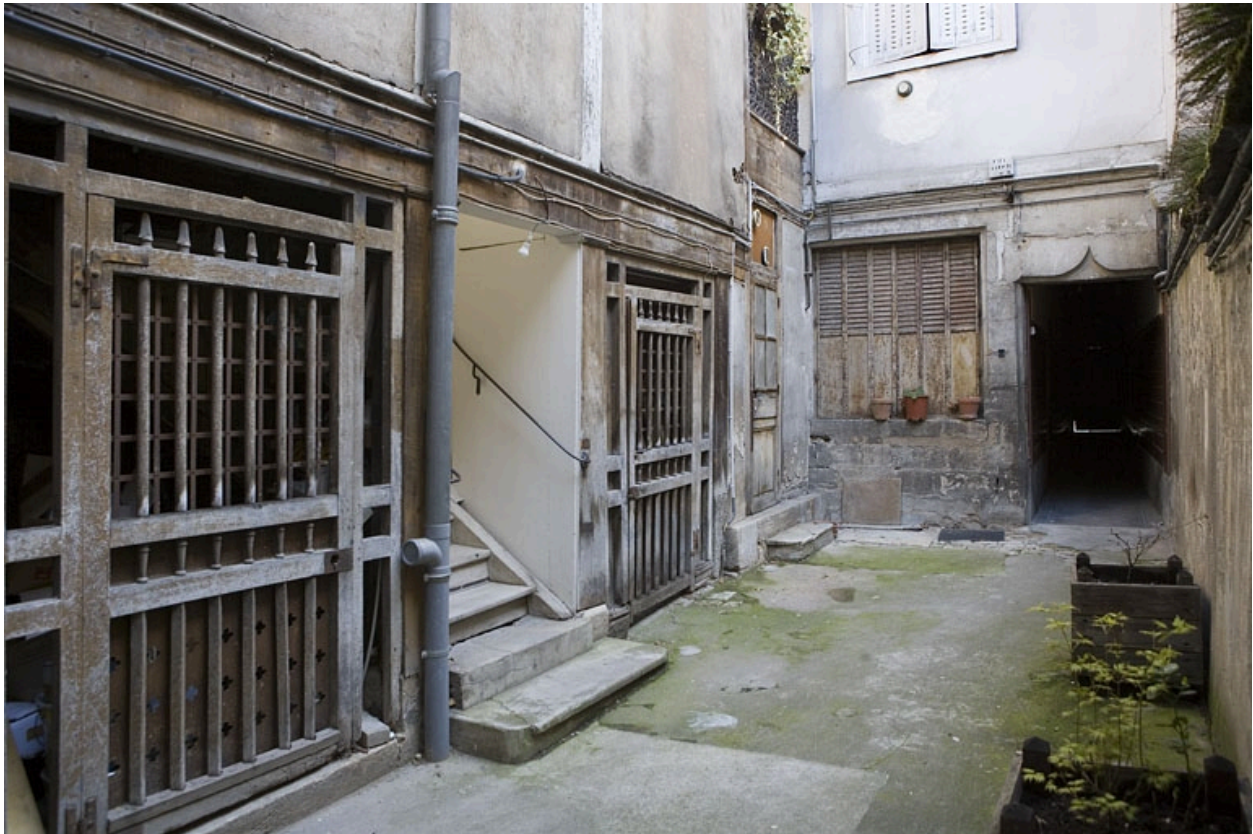
Détail des bûchers et du rez-de-chaussée de la façade postérieure du logis principal.
