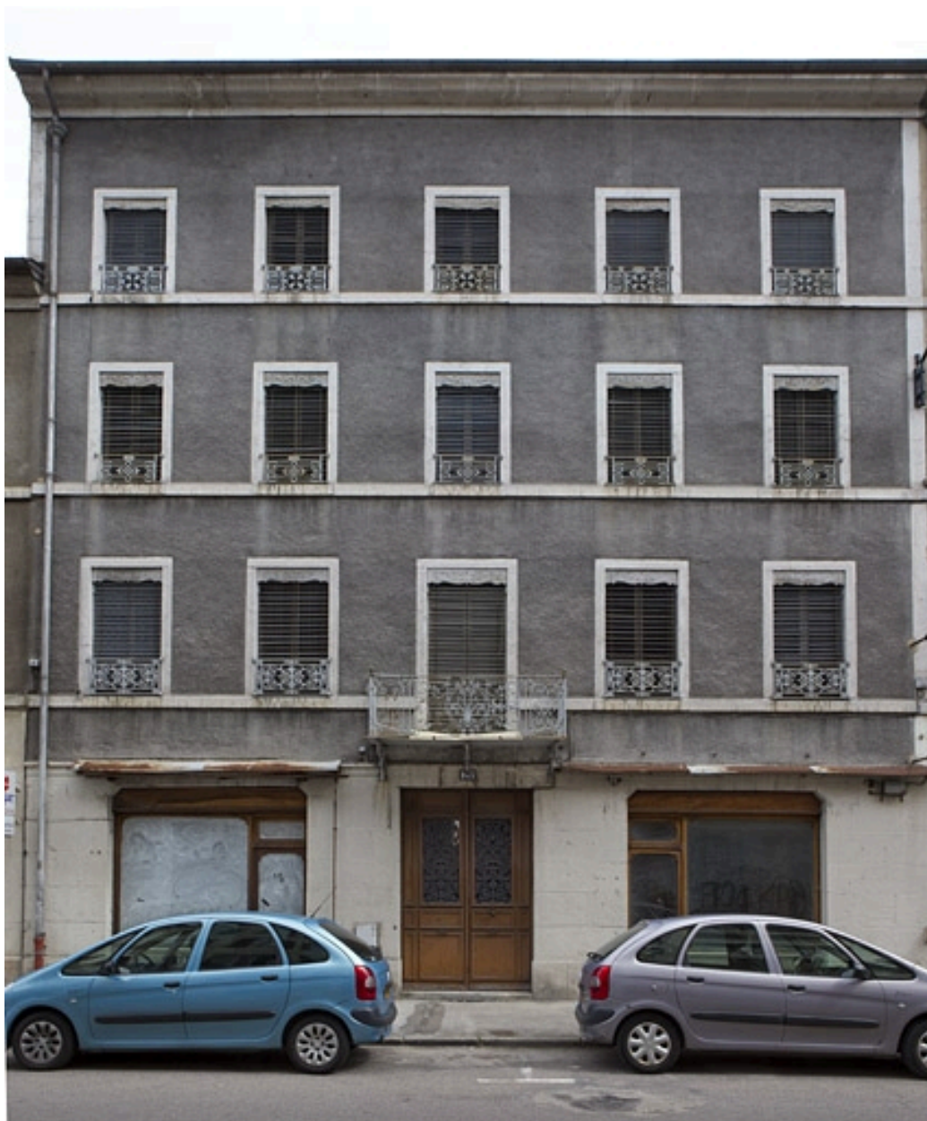
Immeuble, Morez (185 rue de la République et 6 rue Hyacinthe Caseaux) : façade antérieure (rue de la République).
