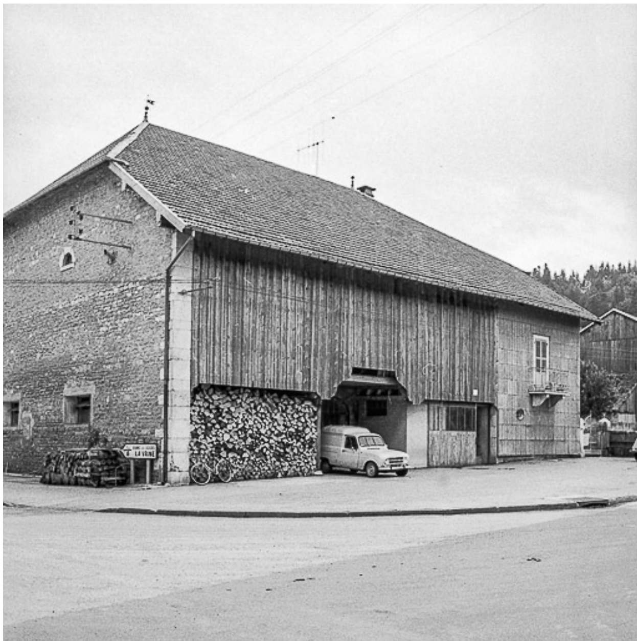
Ferme cadastrée 1962 E 281 bis : façade latérale gauche.
