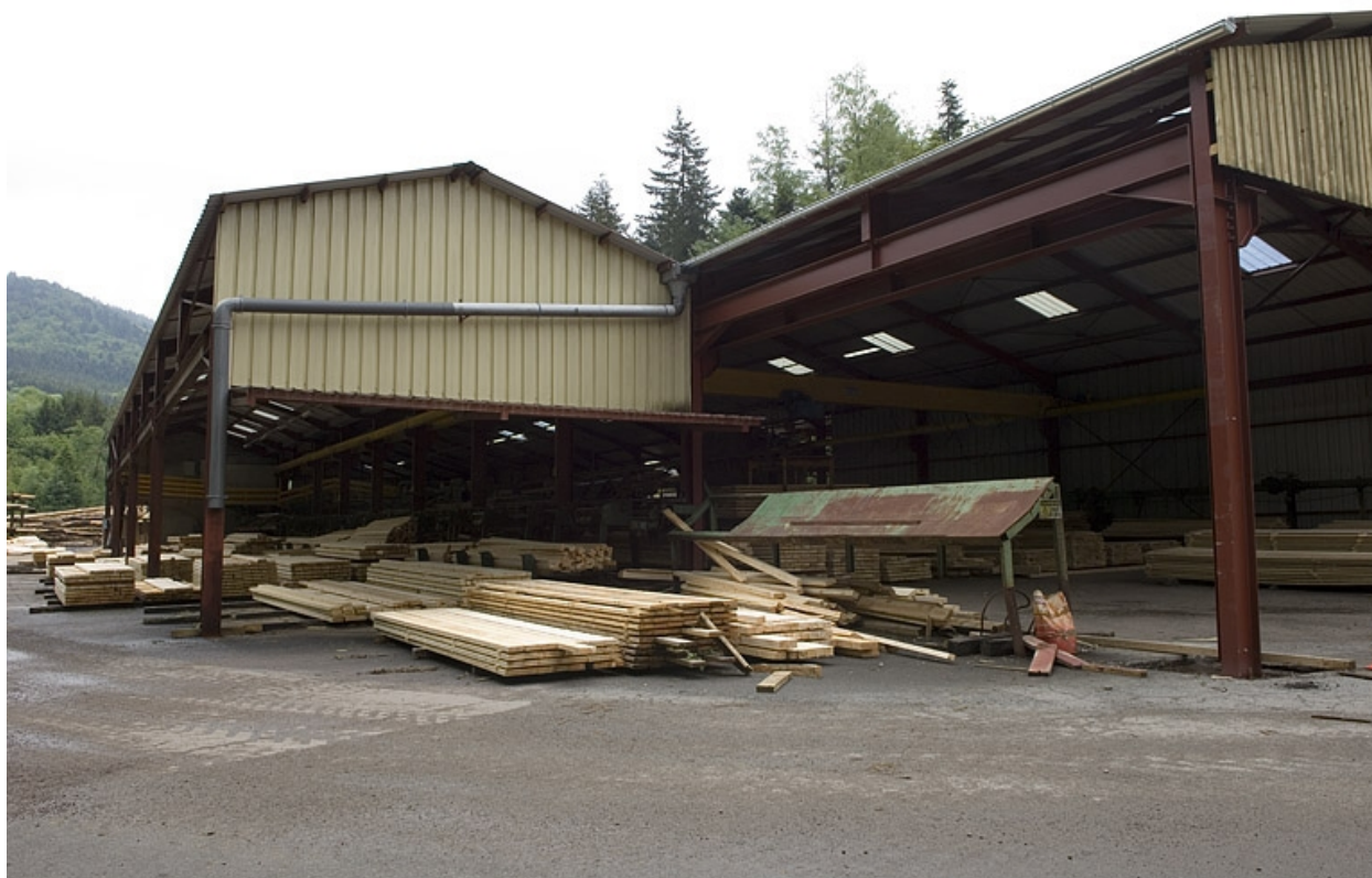
Atelier de fabrication de la nouvelle scierie.
