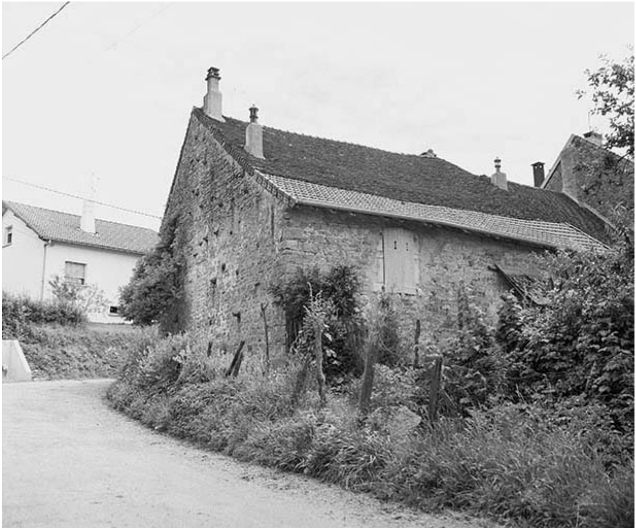
Façades postérieure et latérale droite.
