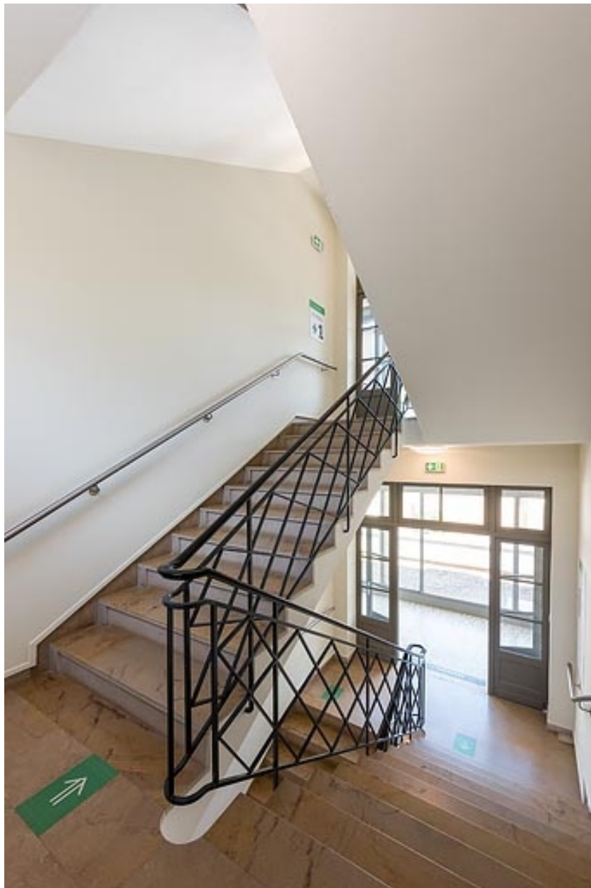
Escalier de l'aile ouest.
