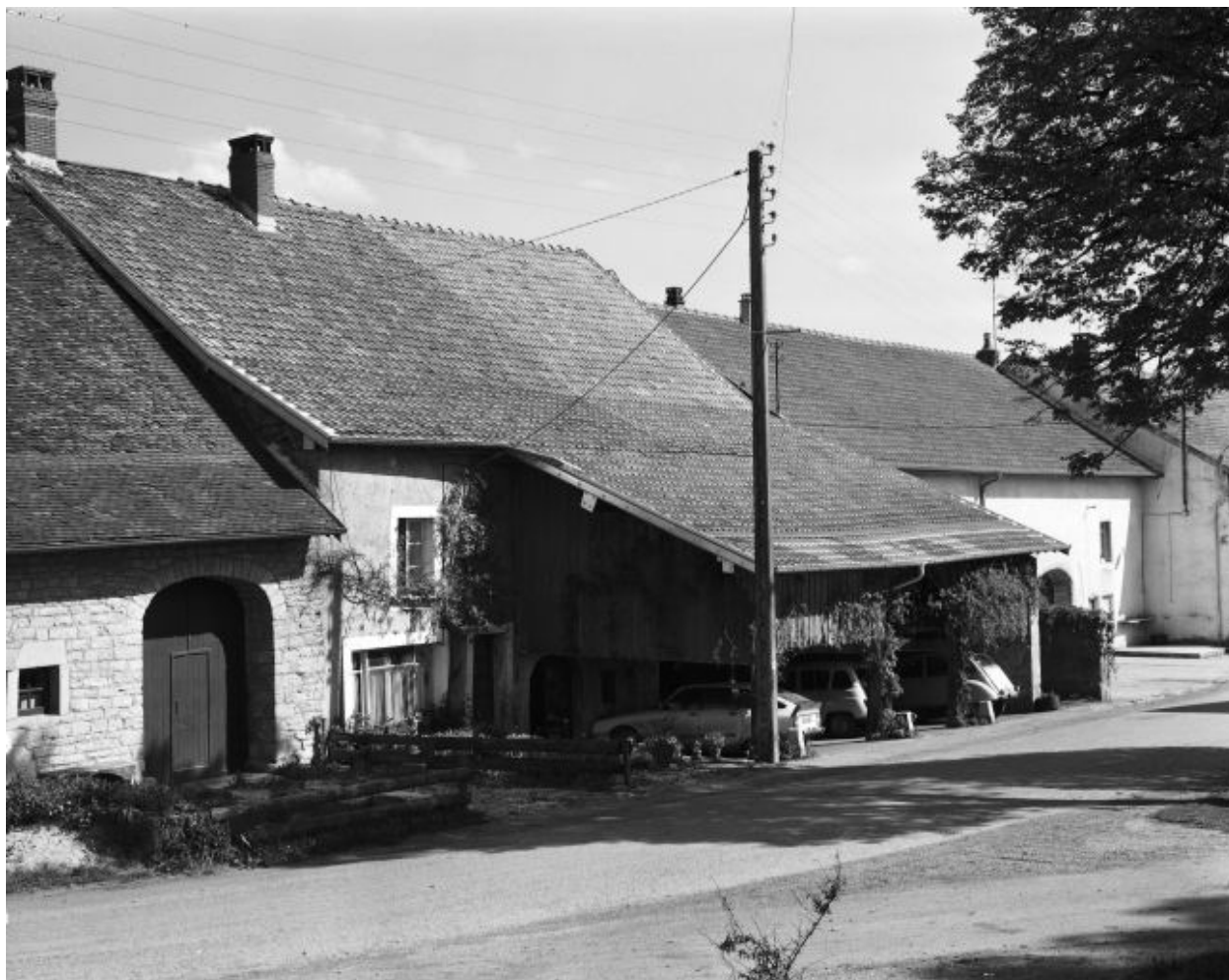
Façade antérieure vue de trois quarts en 1981.
