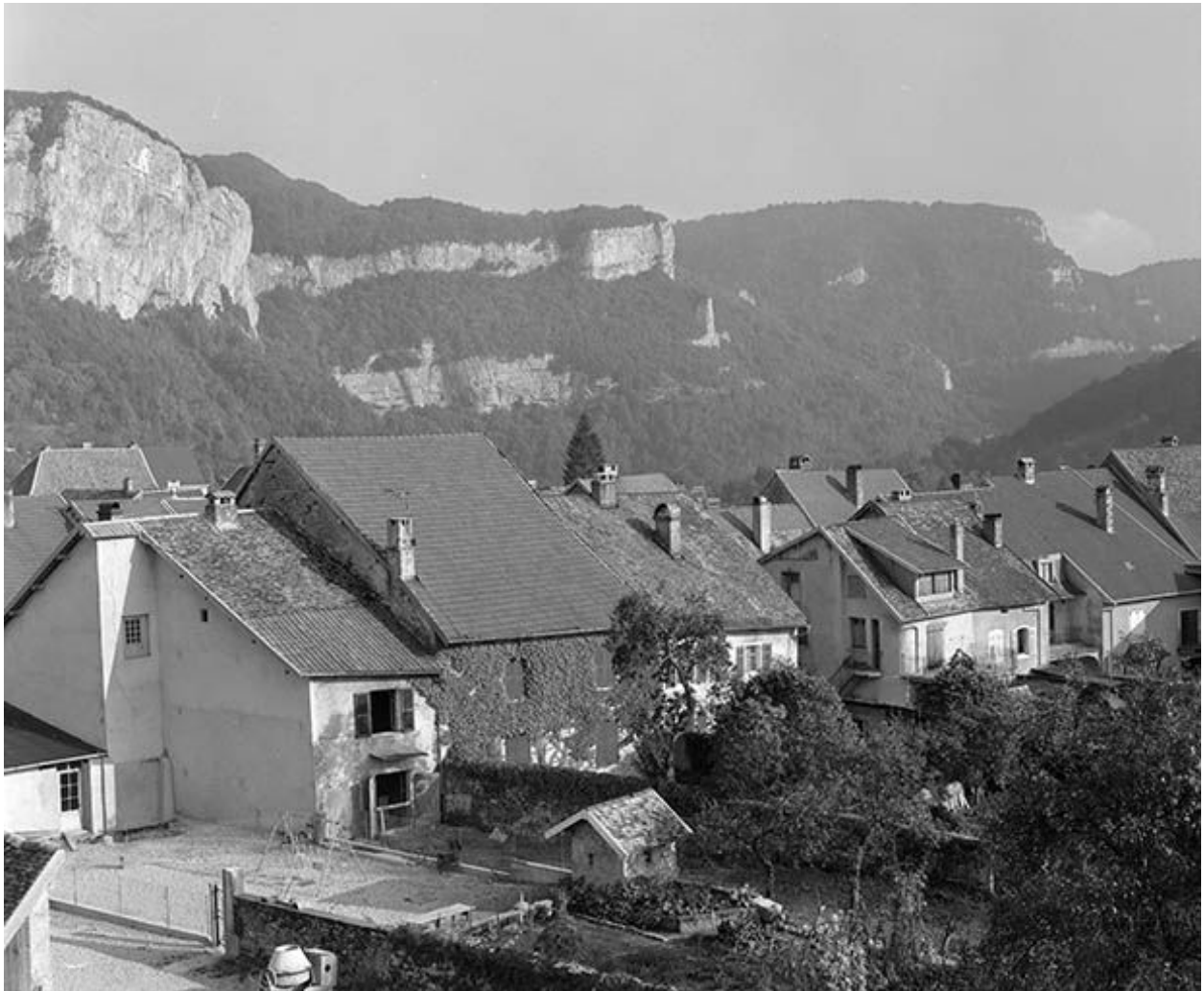
Façades postérieures des maisons de la rue Robert Dame.
